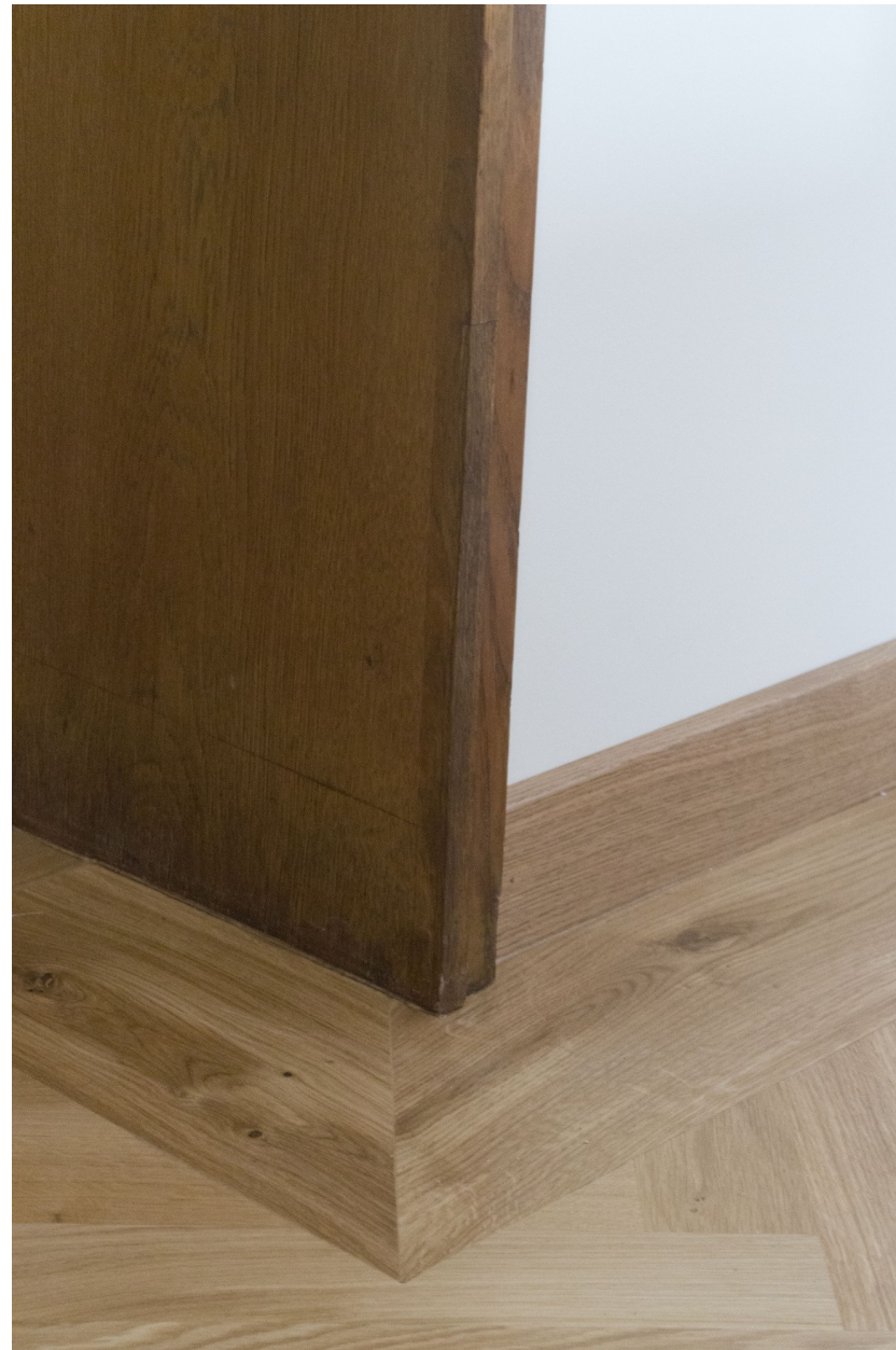
Snímek 14: Hrana rámu u hlavního vchodu – po restaurování
