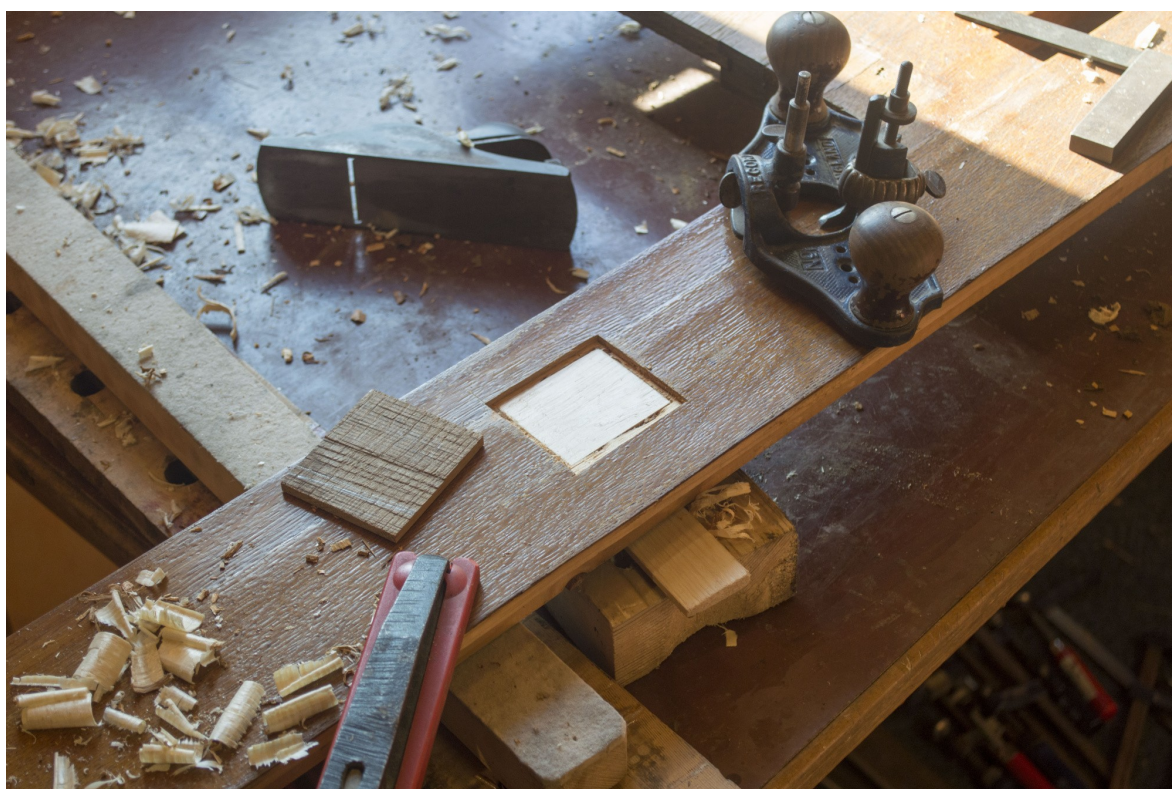
Snímek 75: Rám kolem topení oprava otvoru – průběh restaurování
