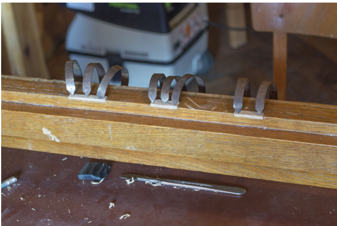
Snímek 77: Rám kolem 2. okna, oprava hrany – průběh restaurování
