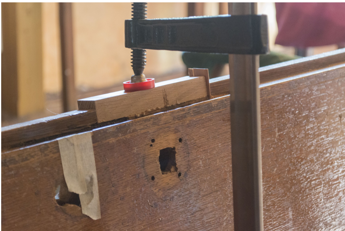
Snímek 64: Pravé dveře do sálu – průběh restaurování
