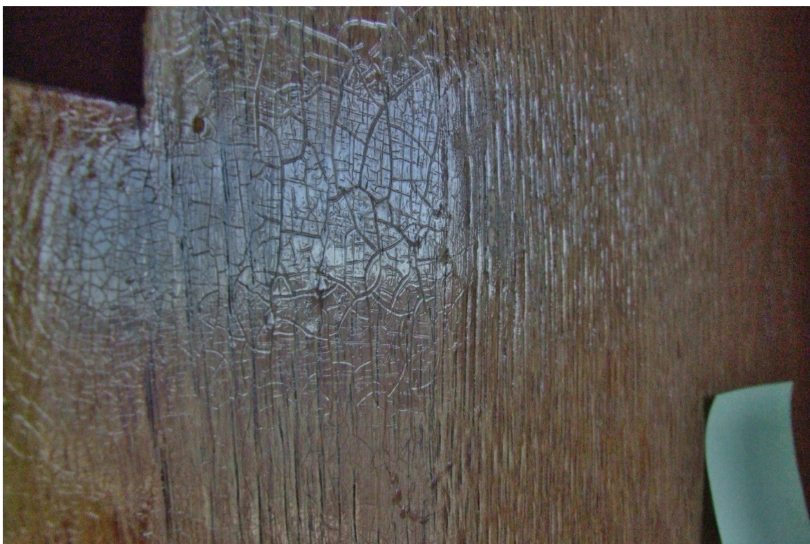
Snímek 35: Detail laku (3. okno) – před restaurováním
