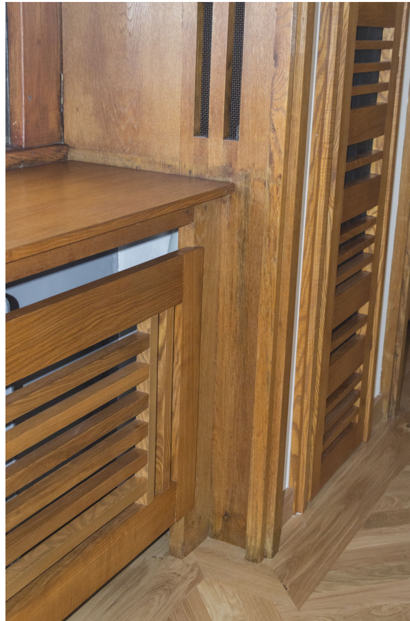
Snímek 28: Obložení u topení (2. okno) – po restaurování
