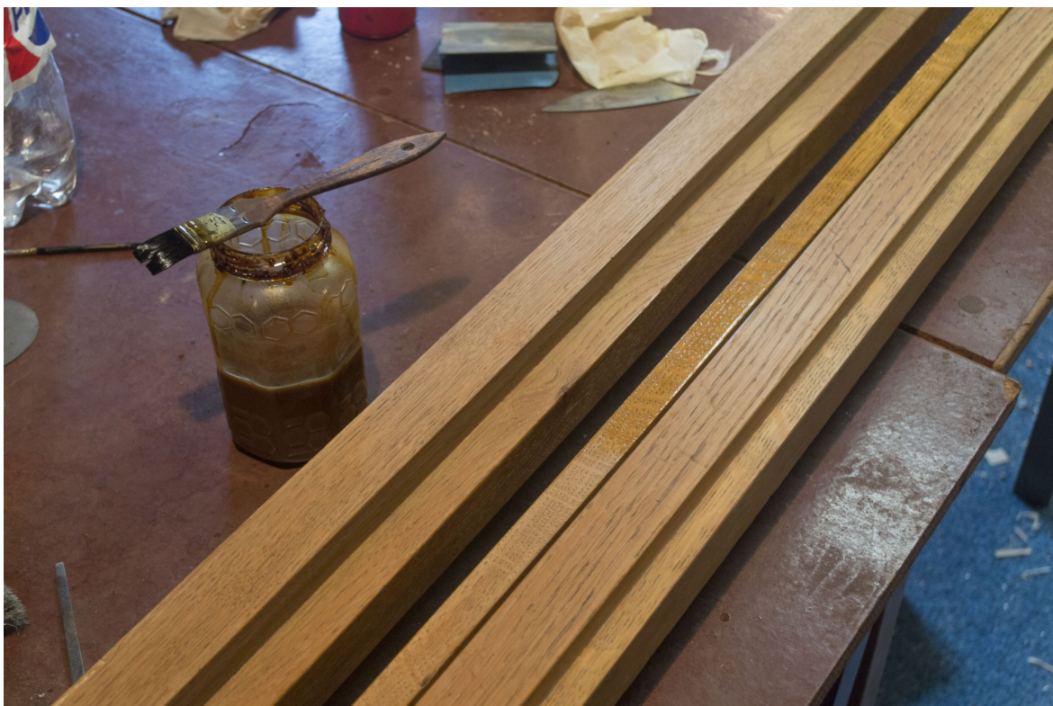
Snímek 86: Lakování rámu kolem oken – průběh restaurování
