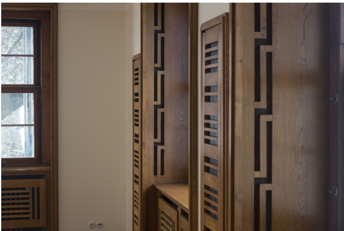
Snímek 99: Pohled na okna s větráním – po restaurování
