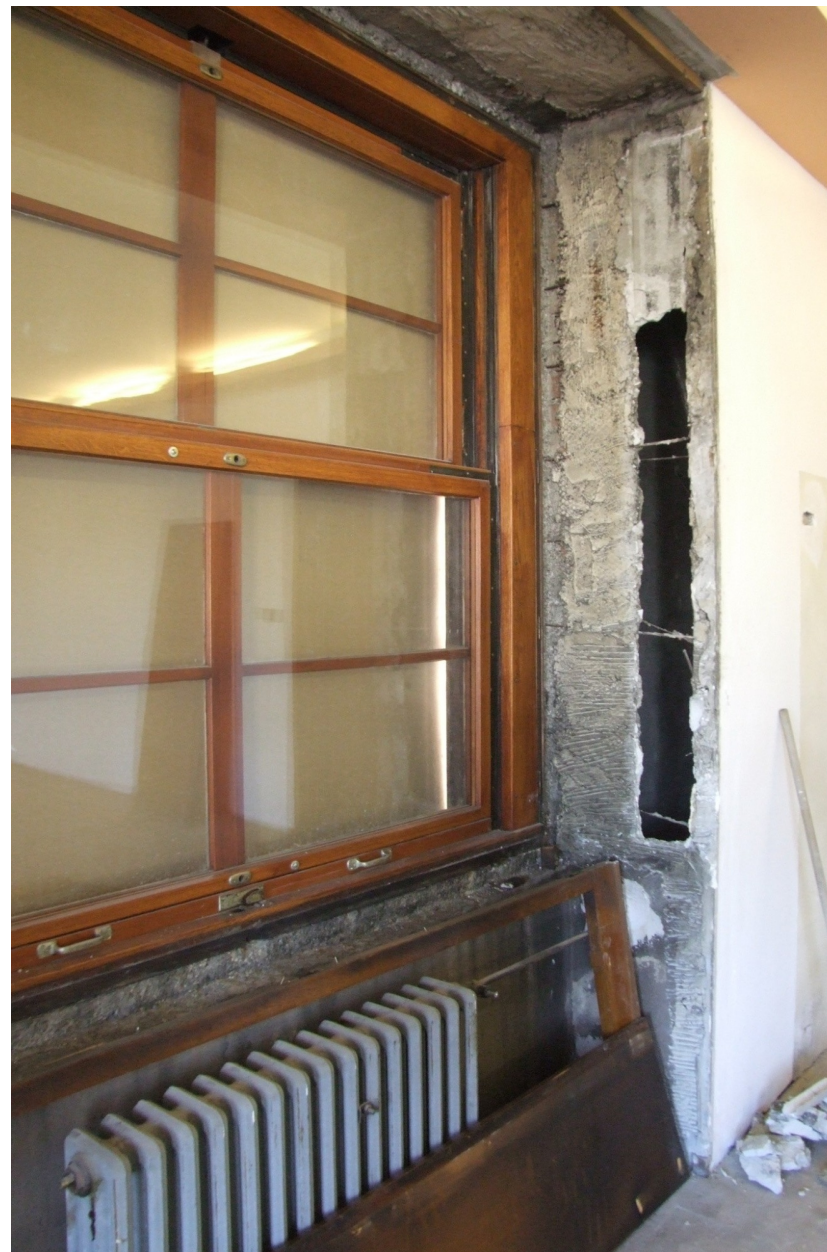
Snímek 38: Demontované 1. okno – před restaurováním
