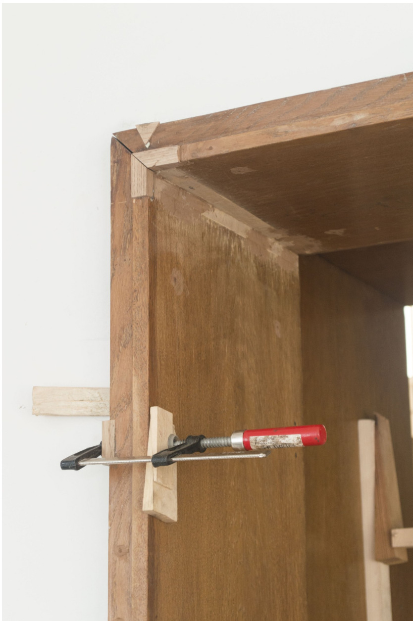
Snímek 87: Oprava zárubně hlavního vchodu – průběh restaurování
