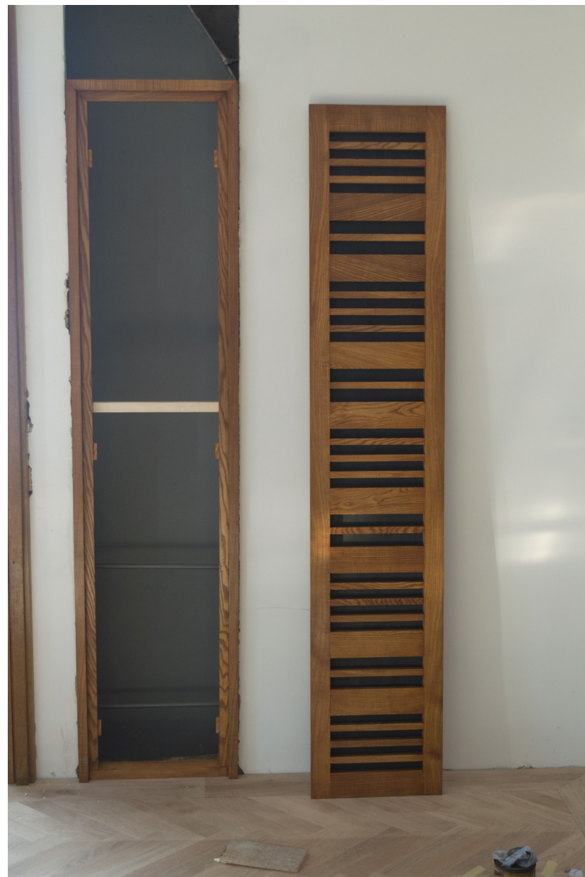
Snímek 88: Připravená konstrukce větrací šachty
