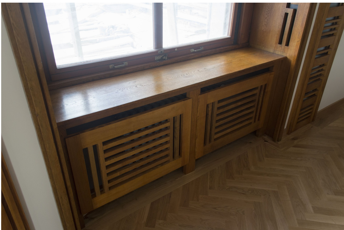
Snímek 20: Obložení u topení (1. okno) – po restaurování
