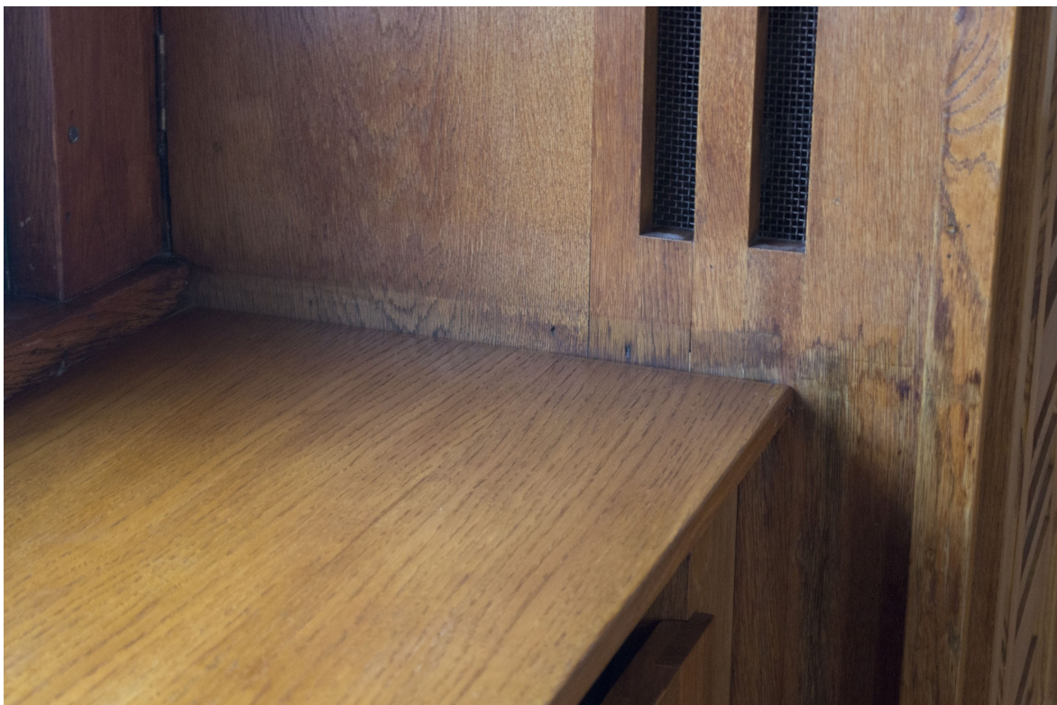
Snímek 24: Okenní obložení a nový parapet – po restaurování
