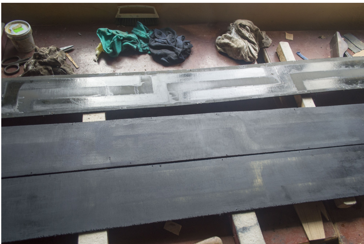
Snímek 79: Čištění pozadí větracích otvorů – průběh restaurování
