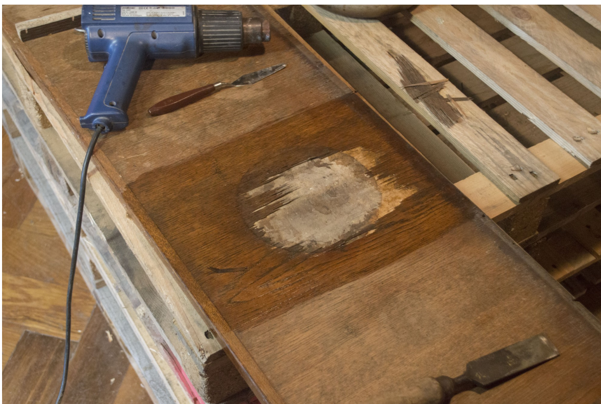
Snímek 81: Odstraňování pásu poškozené dýhy parapetu – průběh restaurování
