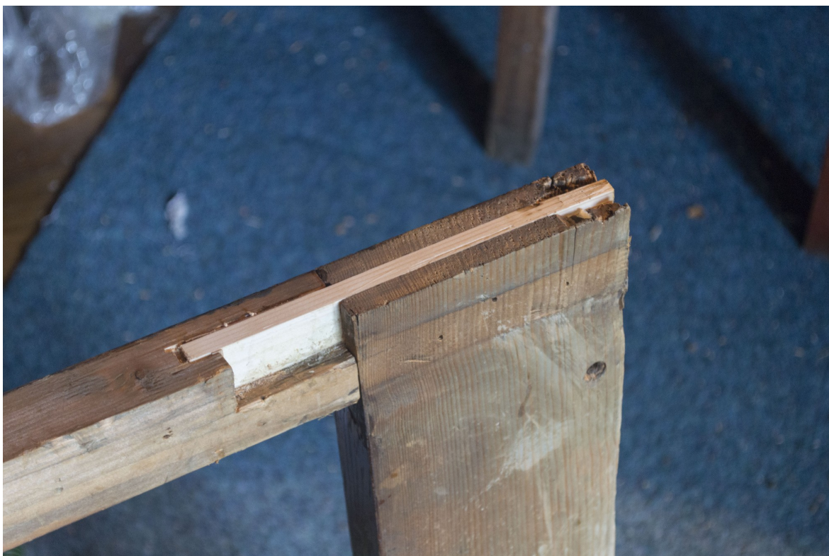
Snímek 74: Rám kolem topení s novým čepem – průběh restaurování
