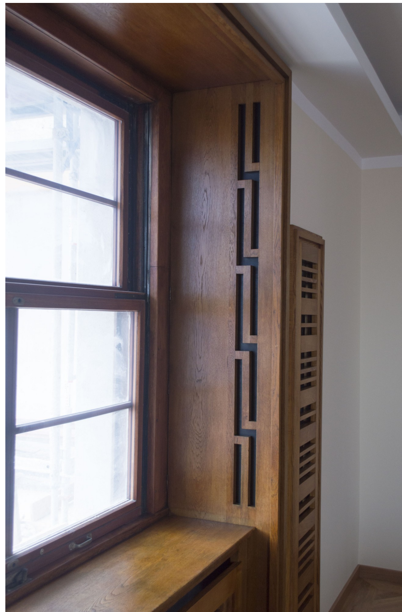
Snímek 12: Bok okenního obložení (1. okno) – po restaurování
