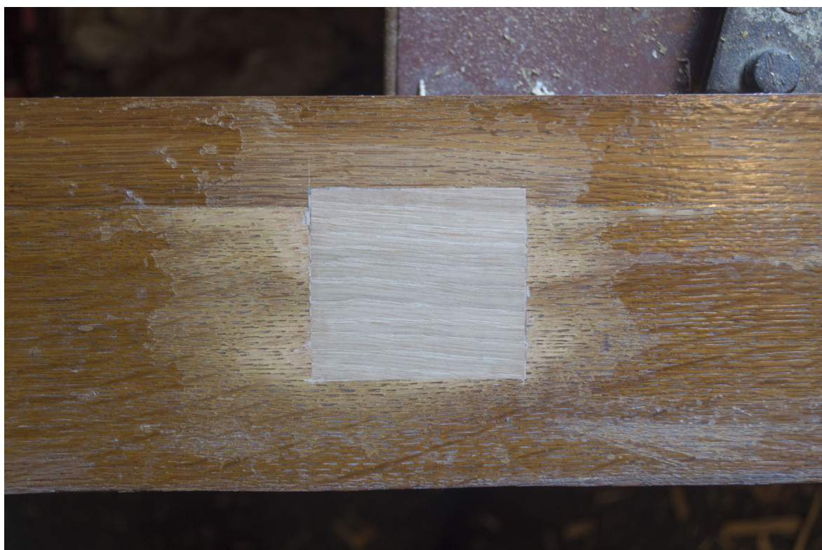
Snímek 76: Rám kolem topení s opravou otvoru – průběh restaurování
