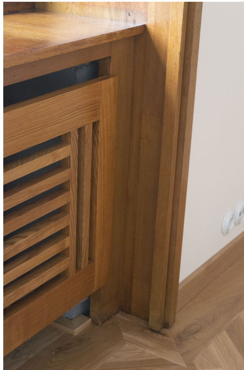
Snímek 26: Obložení u topení (3. okno) – po restaurování
