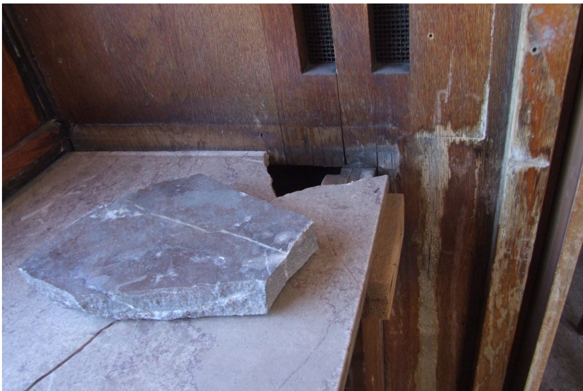
Snímek 23: Okenní obložení a mramor (2. okno) – před restaurováním
