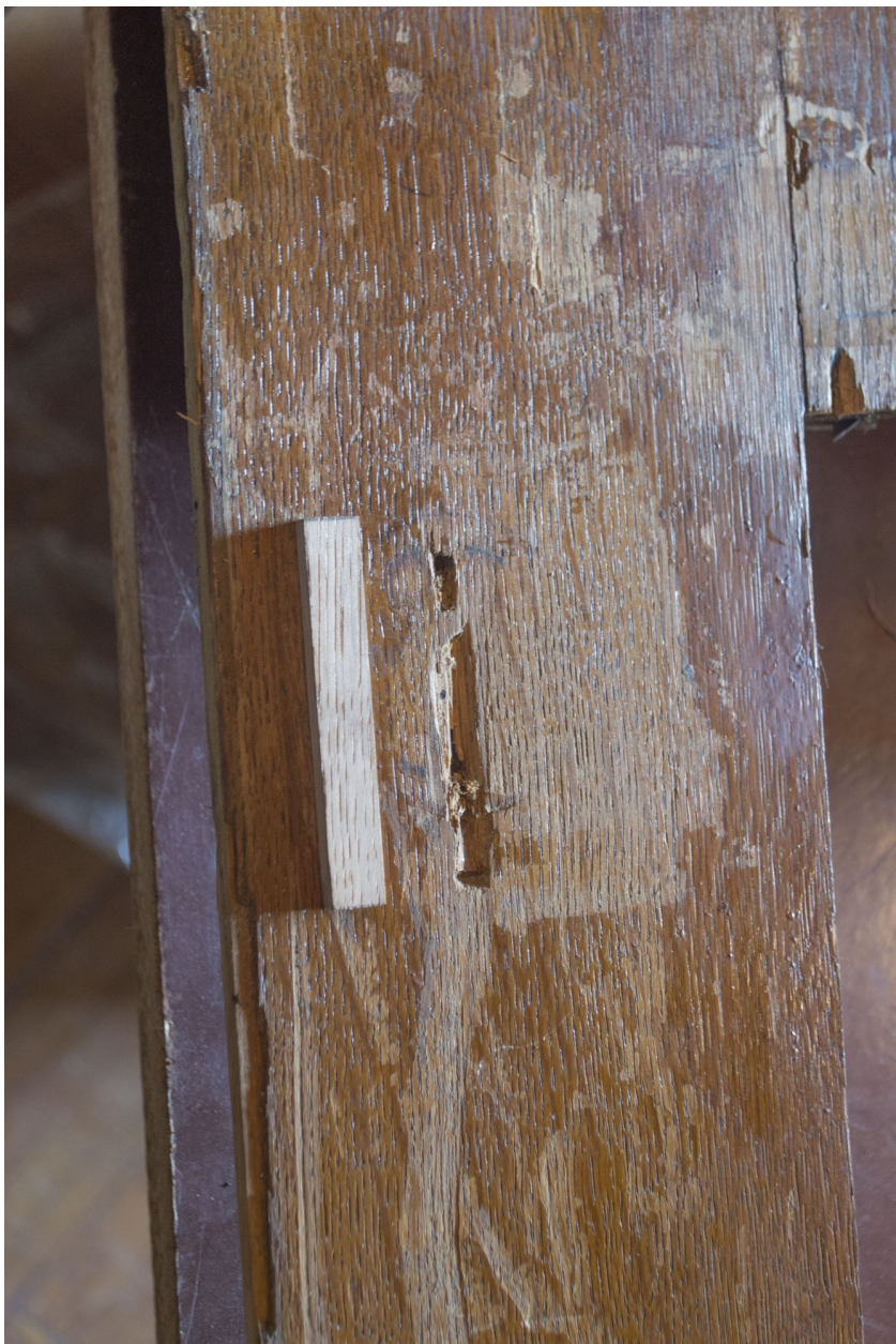
Snímek 61: Detail boku obložení (1. okno) – před restaurováním
