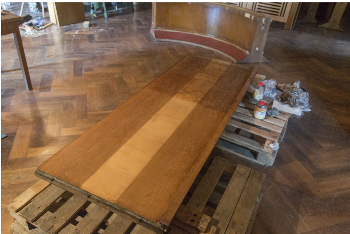
Snímek 80: Čištění hlavních dveří – průběh restaurování
