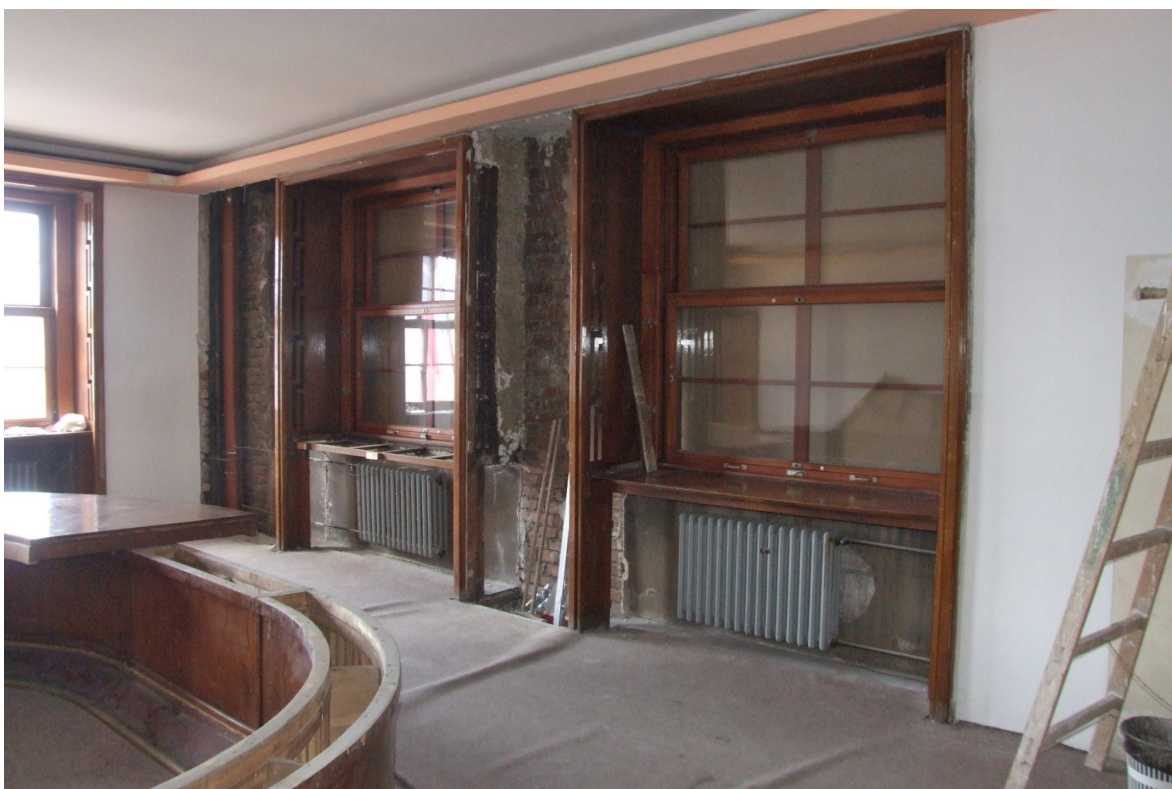
Snímek 31: Pohled na místnost během demontáže
