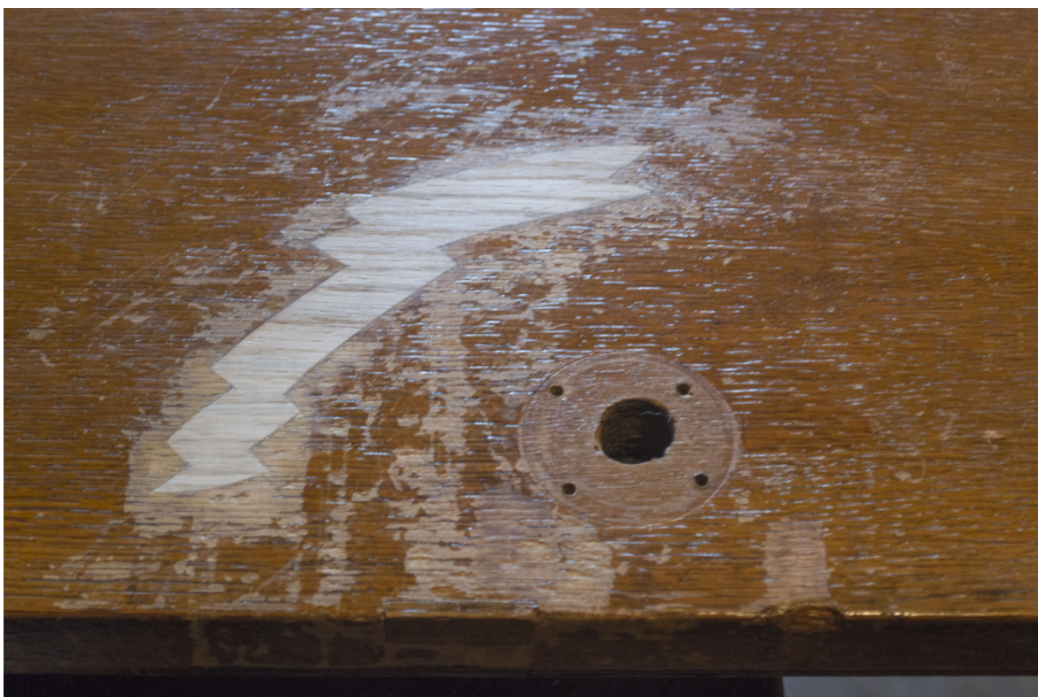
Snímek 63: Levé dveře do sálu – průběh restaurování
