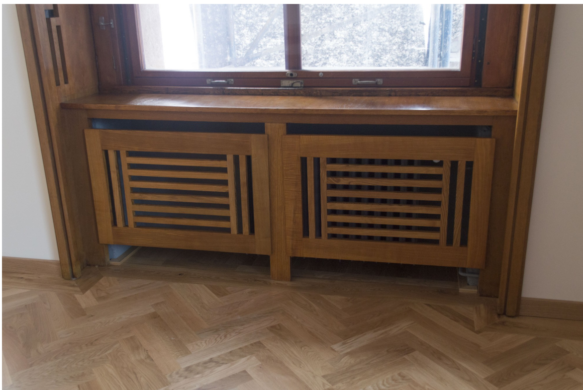
Snímek 98: Konstrukce kolem topení – po restaurování
