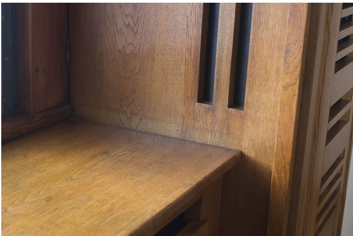
Snímek 18: Okenní obložení a parapet (2. okno) – po restaurování
