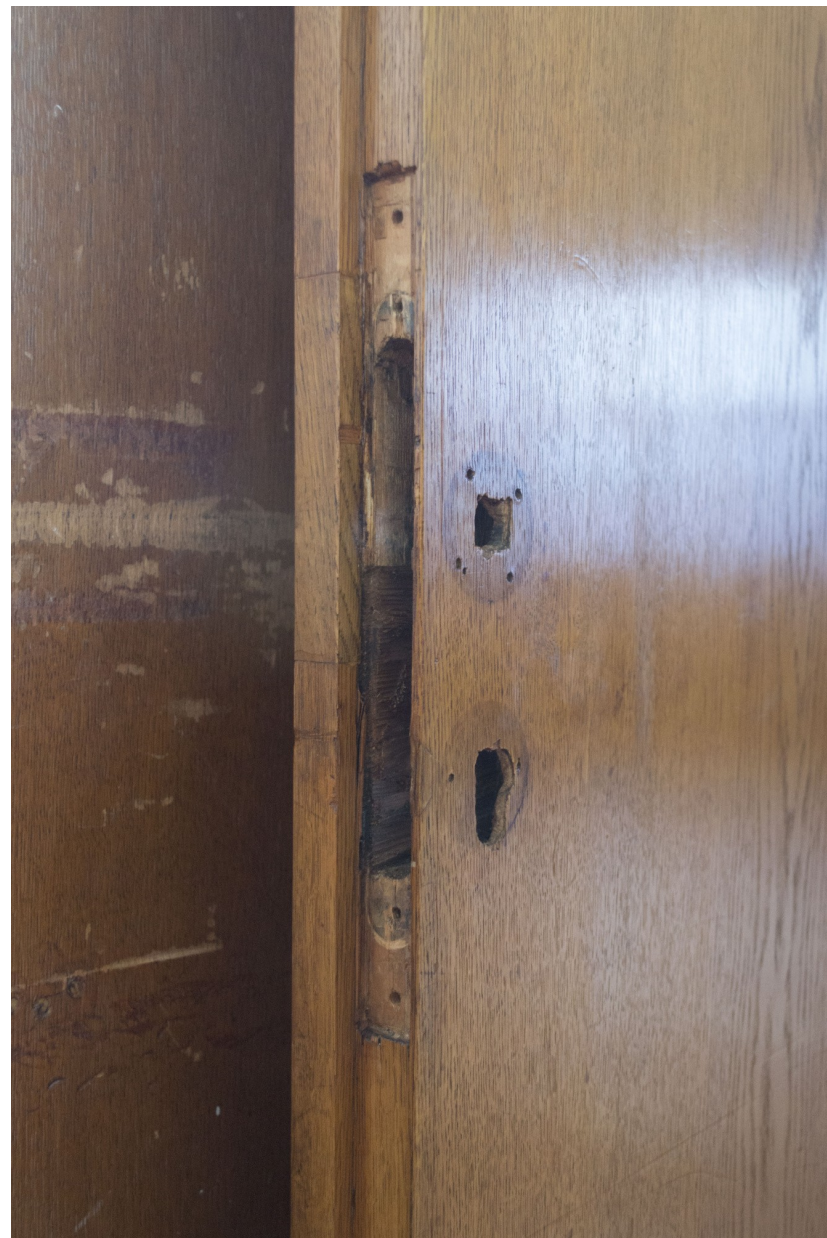
Snímek 40: Právě dveře do sálu – po restaurování
