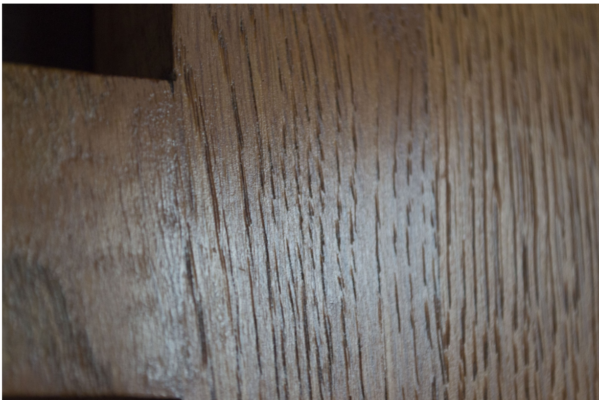
Snímek 36: Detail laku (3. okno) – po restaurování
