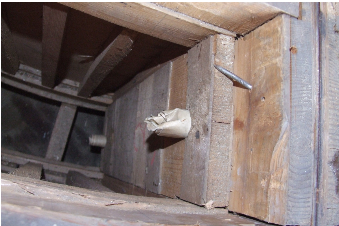
Snímek 6: Vnitřní kostrukce podstavce s čepy – před restaurováním
