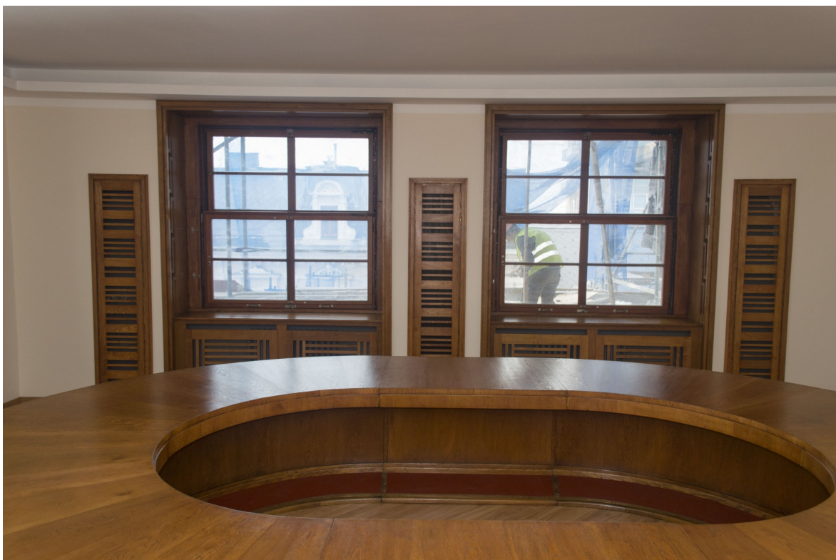
Snímek 96: Pohled na okna s větráním – po restaurování
