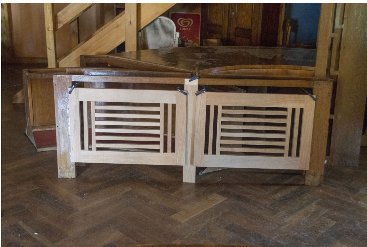
Snímek 73: Rám kolem topení s novými částmi – průběh restaurování
