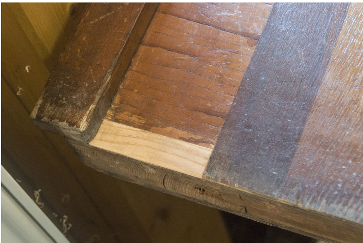
Snímek 66: Opravená dýha hlavních dveří – průběh restaurování
