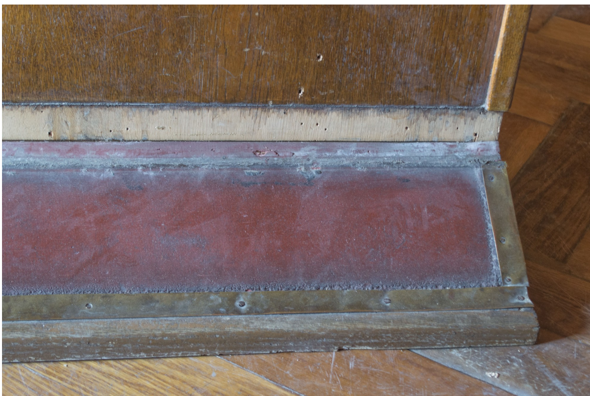
Snímek 55: Detail linolea podstavce – před restaurováním
