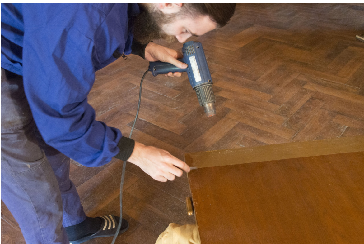
Snímek 65: Odstraňování barvy – průběh restaurování
