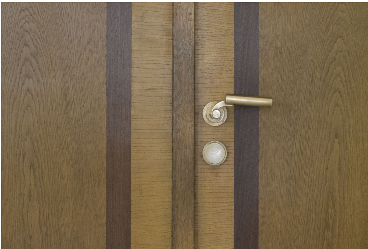
Snímek 46: Detail hlavního vchodu – po restaurování
