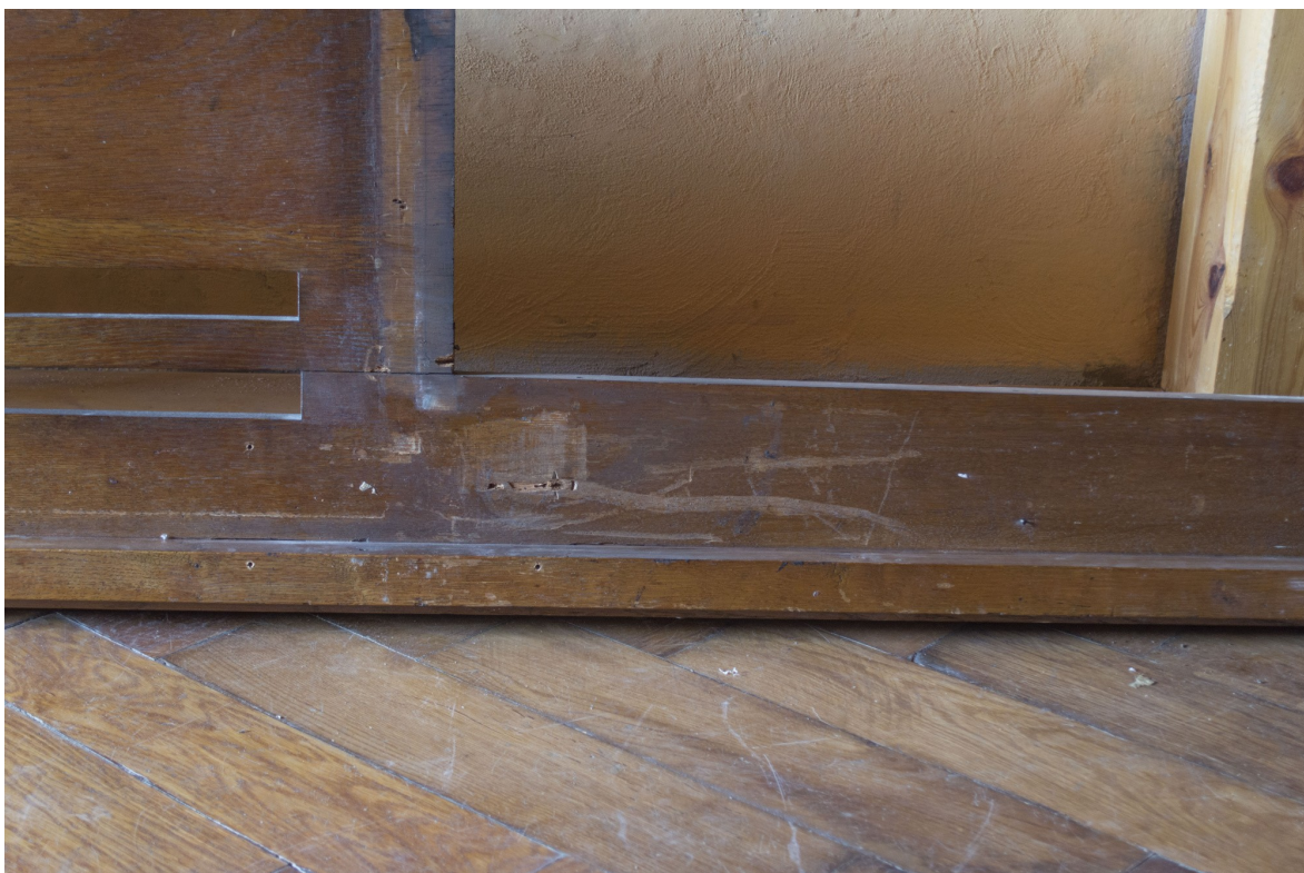
Snímek 48: Bok obložení 2. okna (detail) – před restaurováním
