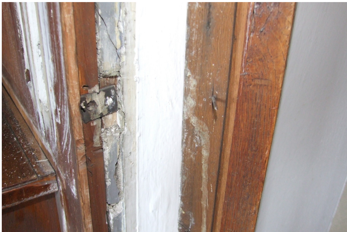
Snímek 34: Demontáž rámu kolem 1. okna
