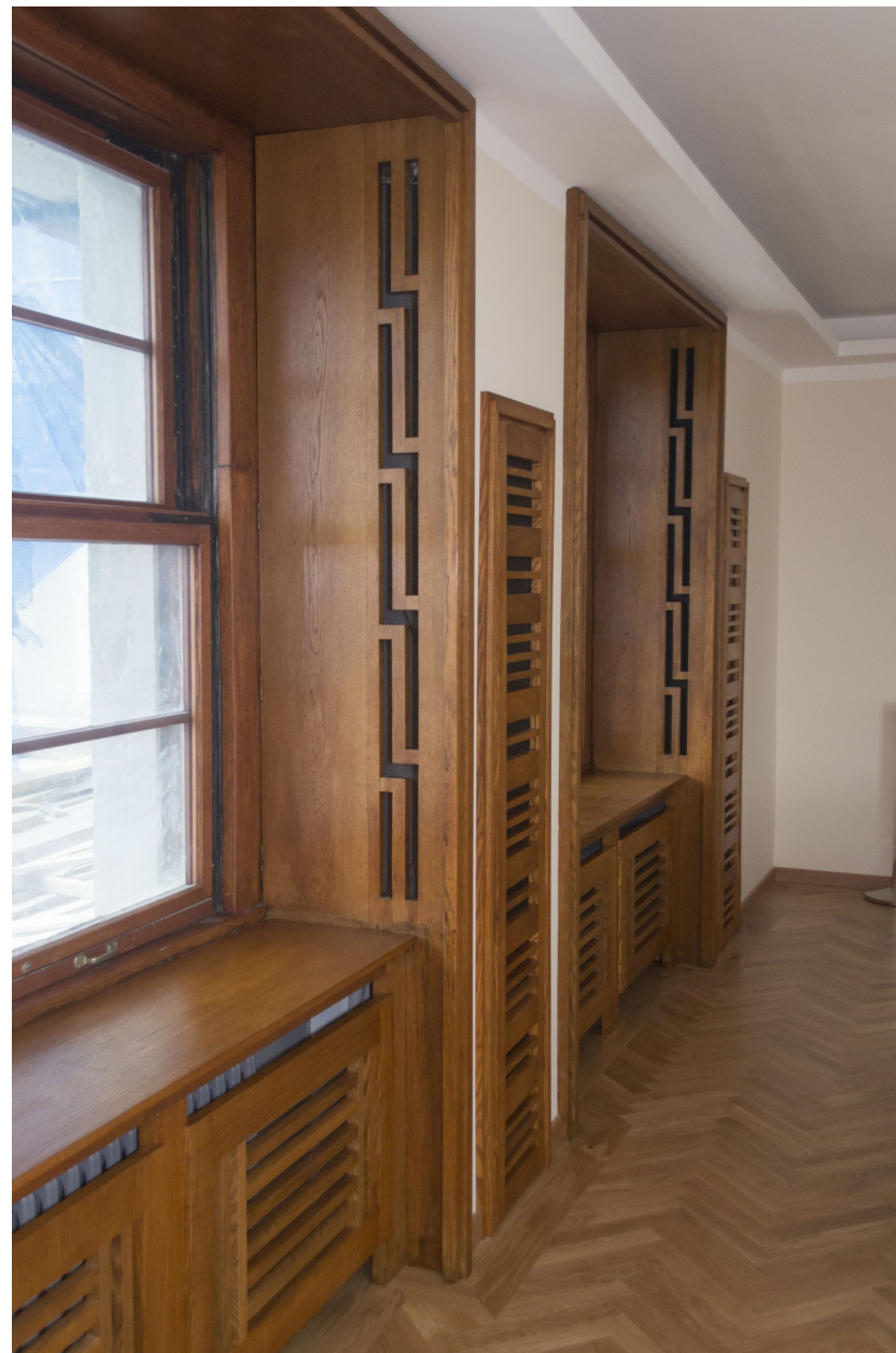
Snímek 94: Pohled na okna a větrací šachty – po restaurování
