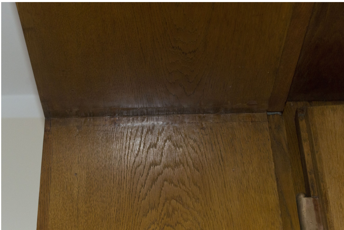
Snímek 22: Detail zárubně hlavního vchodu – po restaurování
