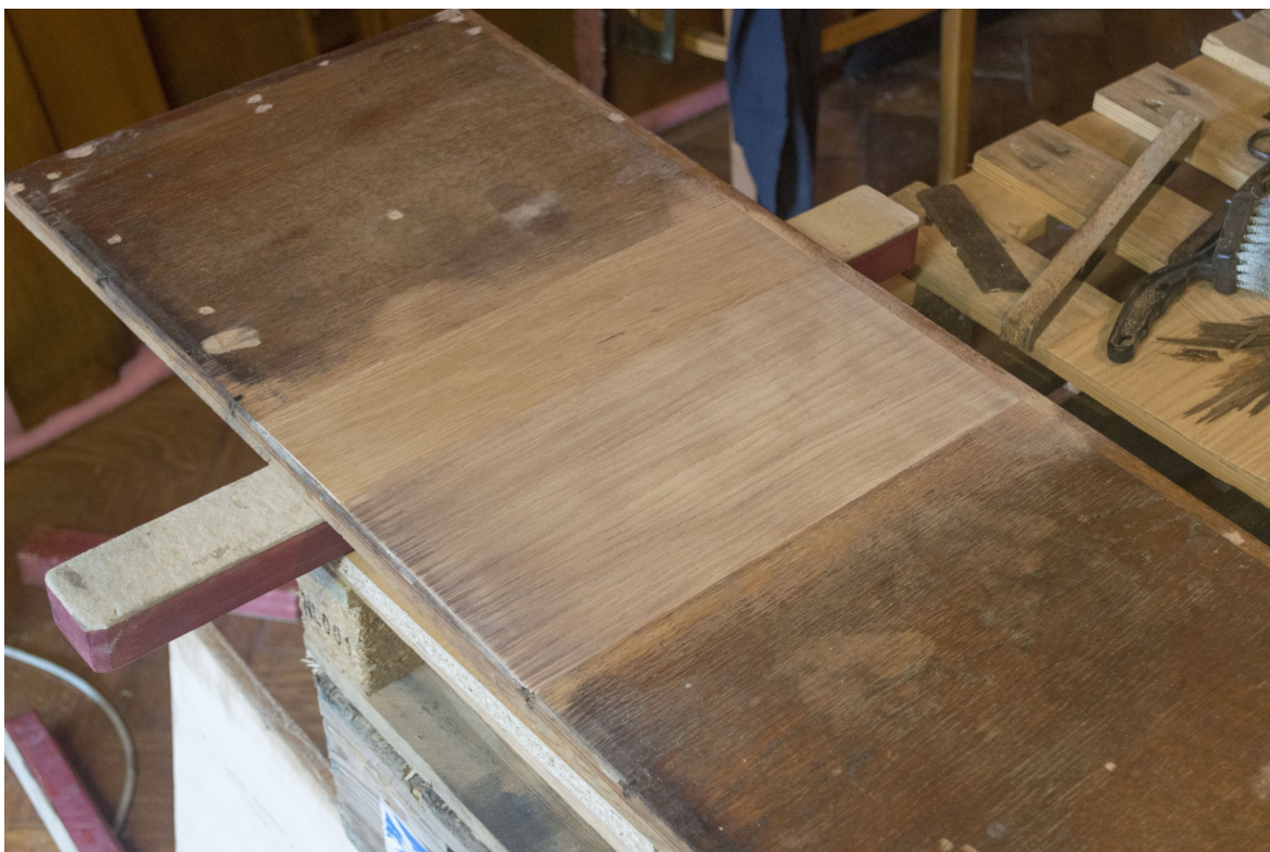
Snímek 82: Nová část dýhy parapetu – průběh restaurování
